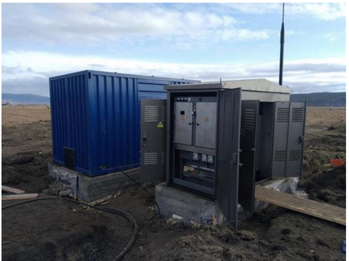
Рисунок 3.1 - Подготовка фундамента под новую трансформаторную подстанцию и генераторный блок (дизельный электрогенератор)
