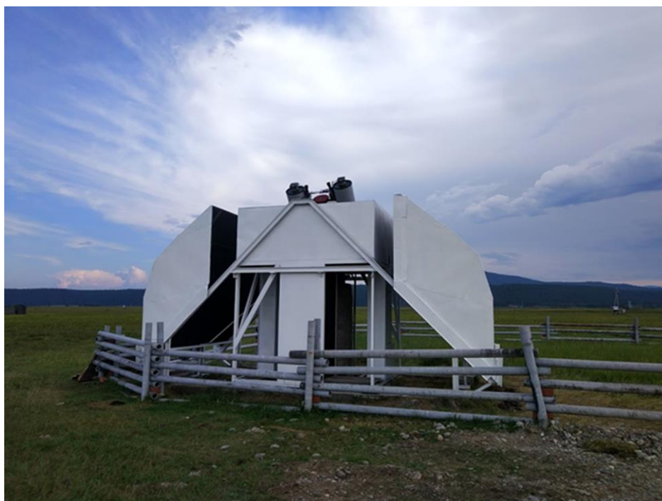
Рисунок 10.3 -Усиленный фундамент и модернизированный астрономический павильон для робот-телескопа МАСТЕР-600 в составе УНУ «Астрофизический комплекс
