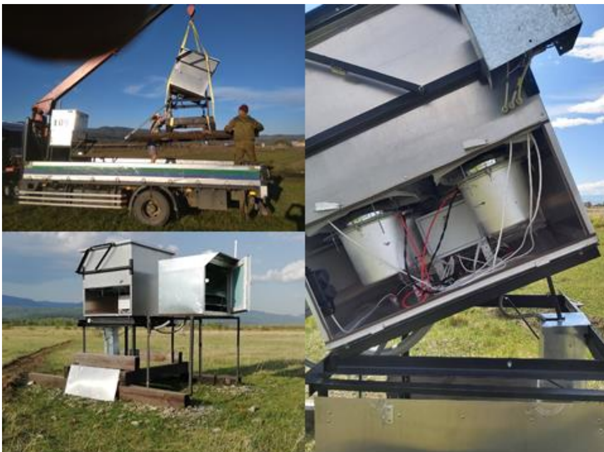
Рисунок 1.2 Монтаж широкоугольной оптической станции 4-ого кластера установки TAIGA-HiSCORE.
