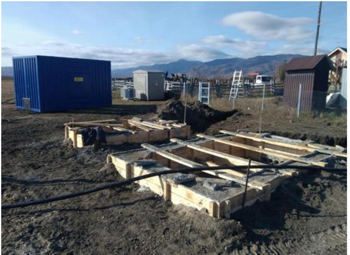
Рисунок 3.1 - Подготовка фундамента под новую трансформаторную подстанцию и генераторный блок (дизельный электрогенератор)
