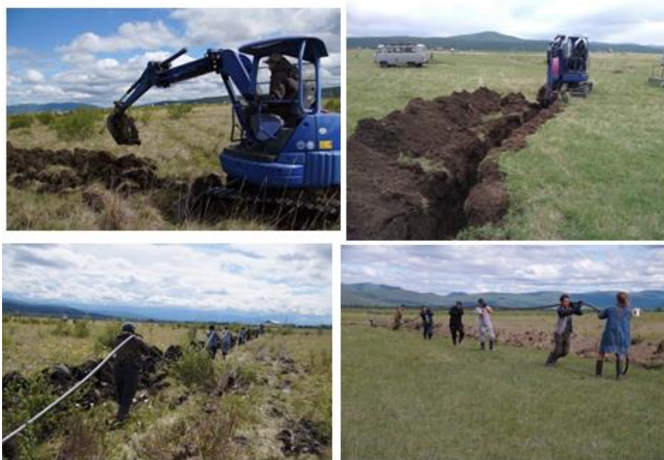
Рисунок 1.4 Прокладка кабеля силового электропитания и оптической линии связи от центра сбора данных гамма-обсерватории TAIGA до локального центра сбора данных 4 кластера установки TAIGA-HiSCORE.
