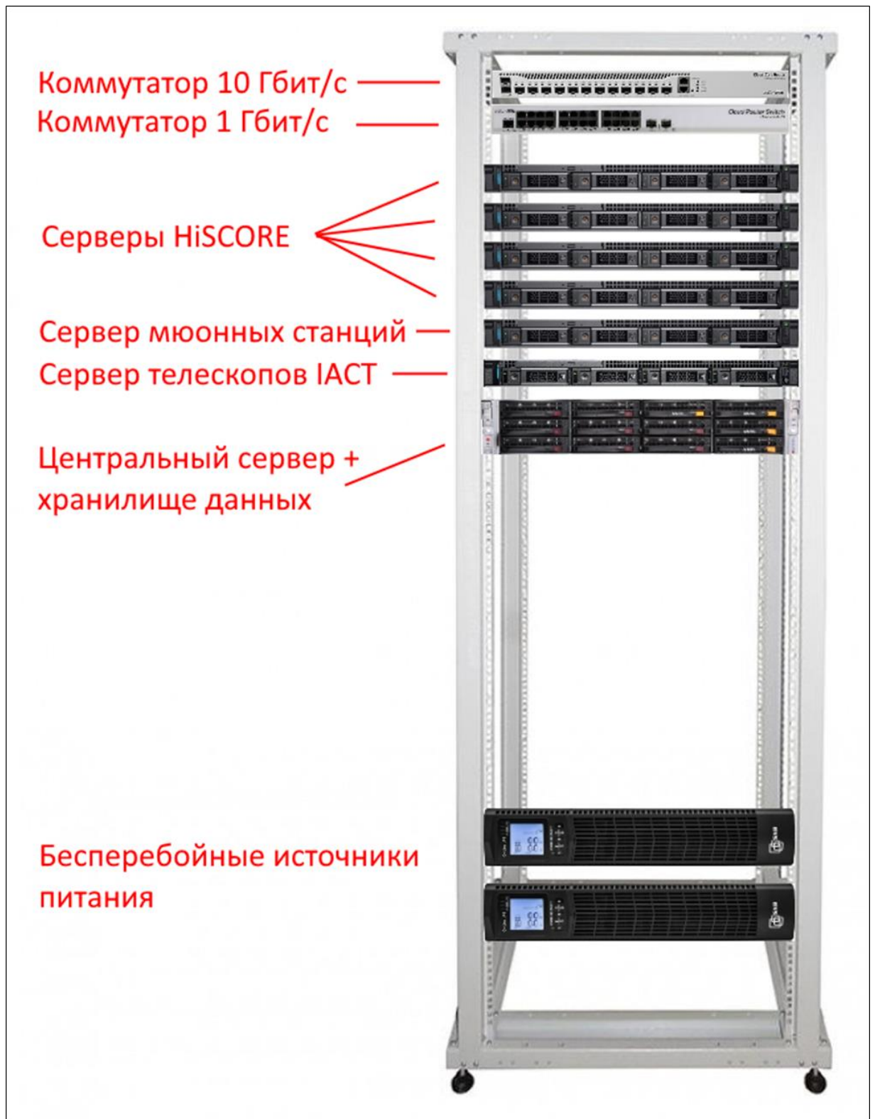
Рис. 2.1 - Стойка с оборудованием системы сбора и хранения данных УНУ «Астрофизический комплекс МГУ-ИГУ»,
