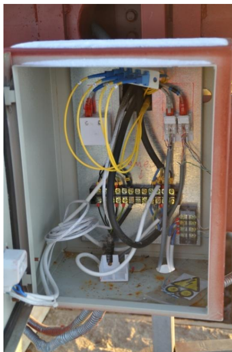
Рисунок 1.14 - Щиток подключения магистралей гибкого кабель-канала
