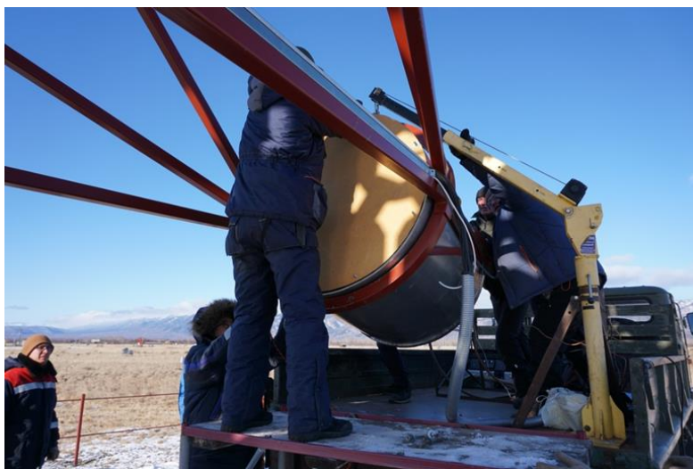
Рисунок 1.8. Установка камеры на 2-й телескопустановки TAIGA-IACT.
