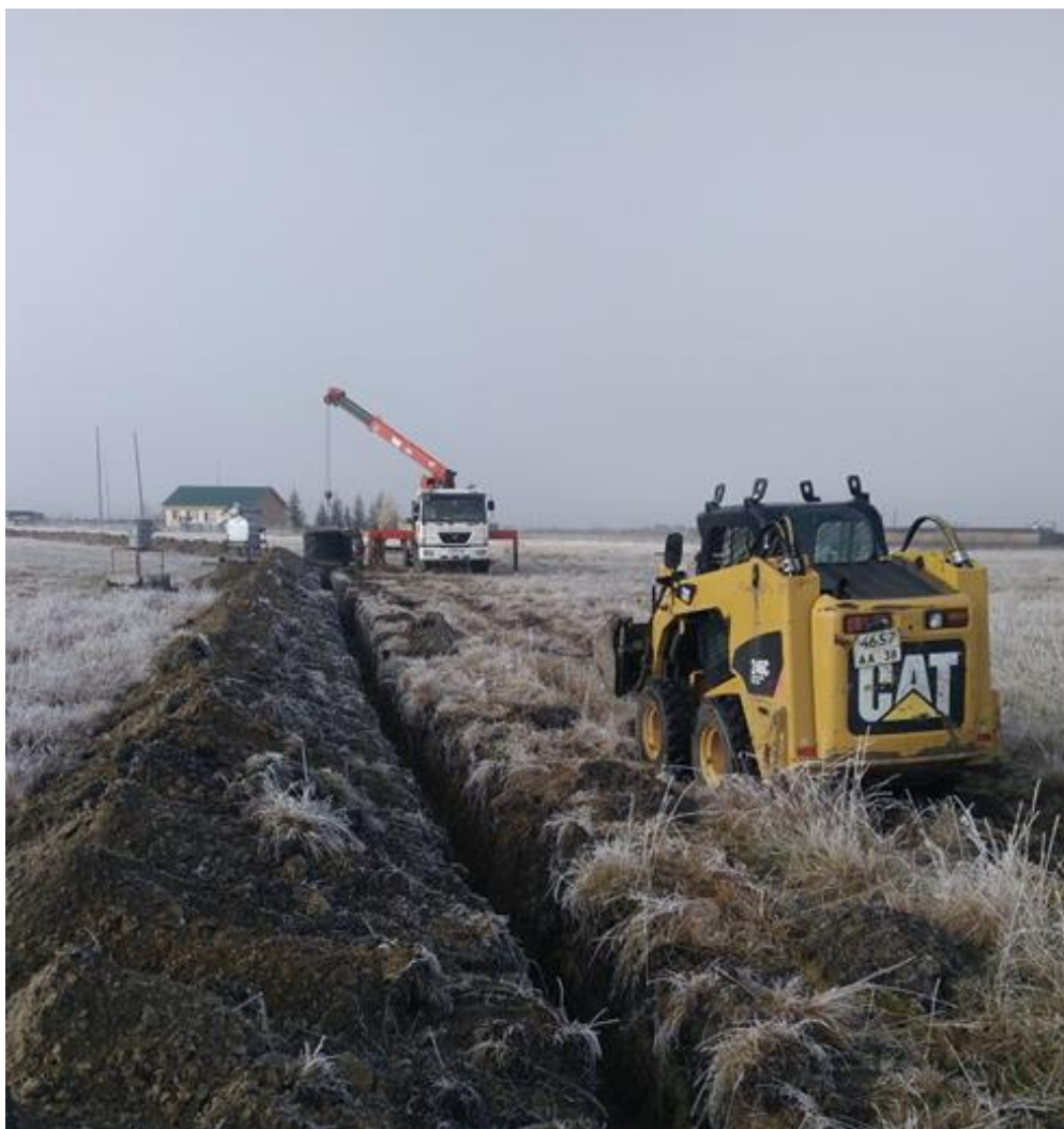
Рисунок 3.3 - Копка траншеи механизированной техникой между новой подстанцией и зданием Центра Сбора Данных УНУ «Астрофизический комплекс МГУ-ИГУ»
