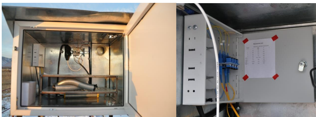
Рисунок 1.13 Контейнер ввода электропитания и оптических линий связи.
