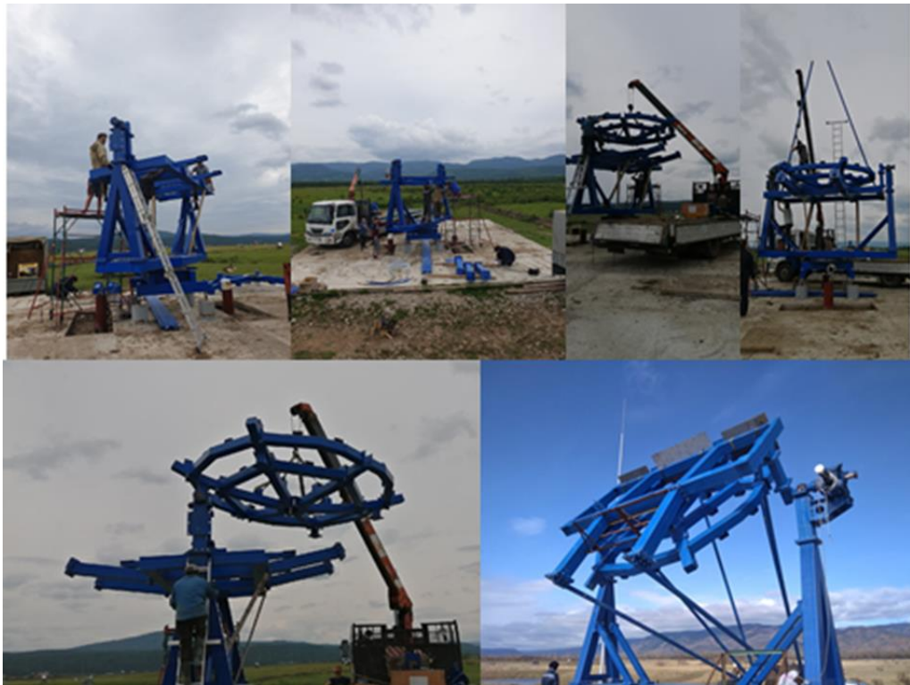
Рисунок 1.12 Сборка третьего АЧТ установки TAIGA-IACS
